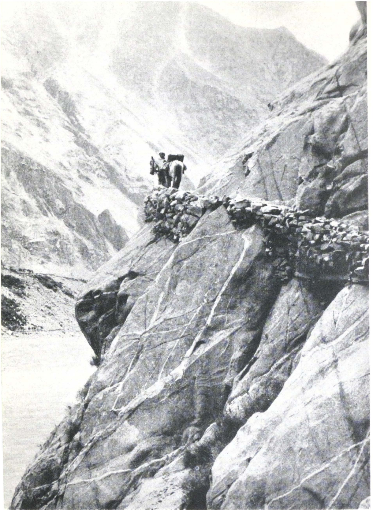
Mit genialer Statik ist die alte Handels-„Straße“, der einzige Zugang ins Hunzaland, an den glatten Fels geklebt.
